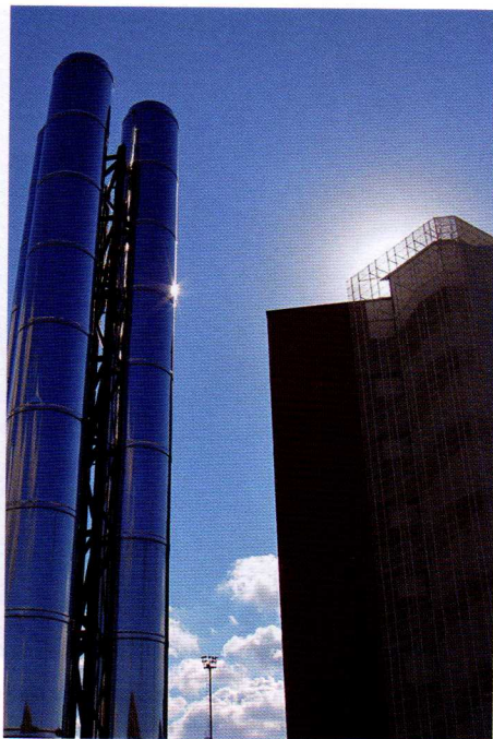
I vani tecnologici periferici al nosocomio sono isolati dal resto del complesso
